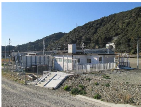
<市屋ポンプ場>
