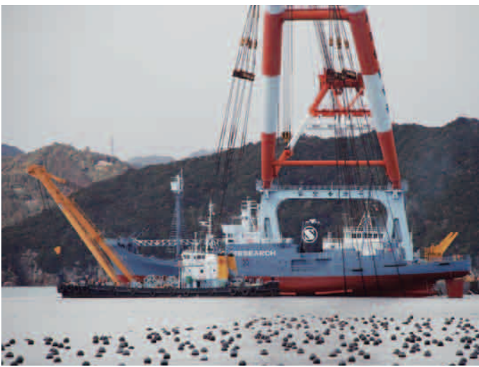
作業段階①
