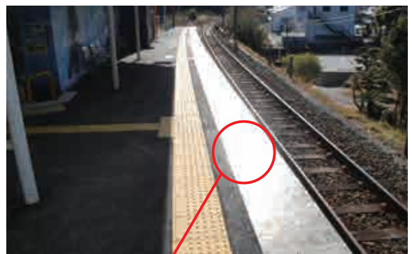
改良工事箇所
