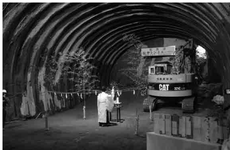
山中2号線トンネル貫通式
