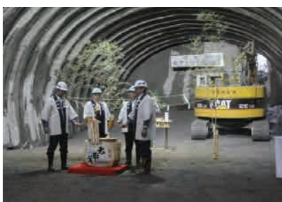
山中2号線トンネル貫通式
