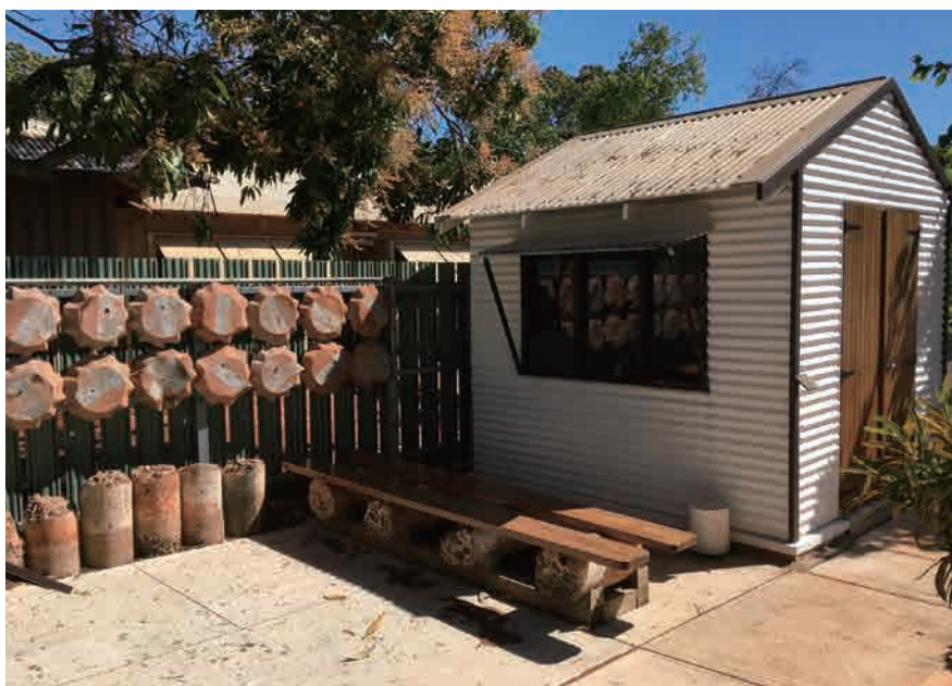
ふたりの修道女の、ブルームにおける最初の家となった小屋が、それが建っていた場所に復元されている。掘り出された円柱コンクリートの礎石と、その上に被せられていた鉄製のキャップは実物で、シロアリから小屋を守るための工夫であった。
