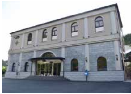
駅舎防災複合施設竣工
